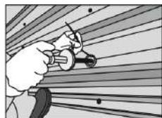
5. Gire y apriete el cáncamo hasta que no queden hilos visibles, asegurando que la base del anclaje quede al nivel del recubrimiento o techumbre.
